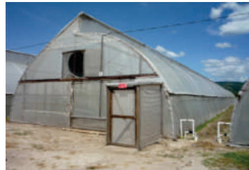
Foto 34. Estructura de invernadero.
